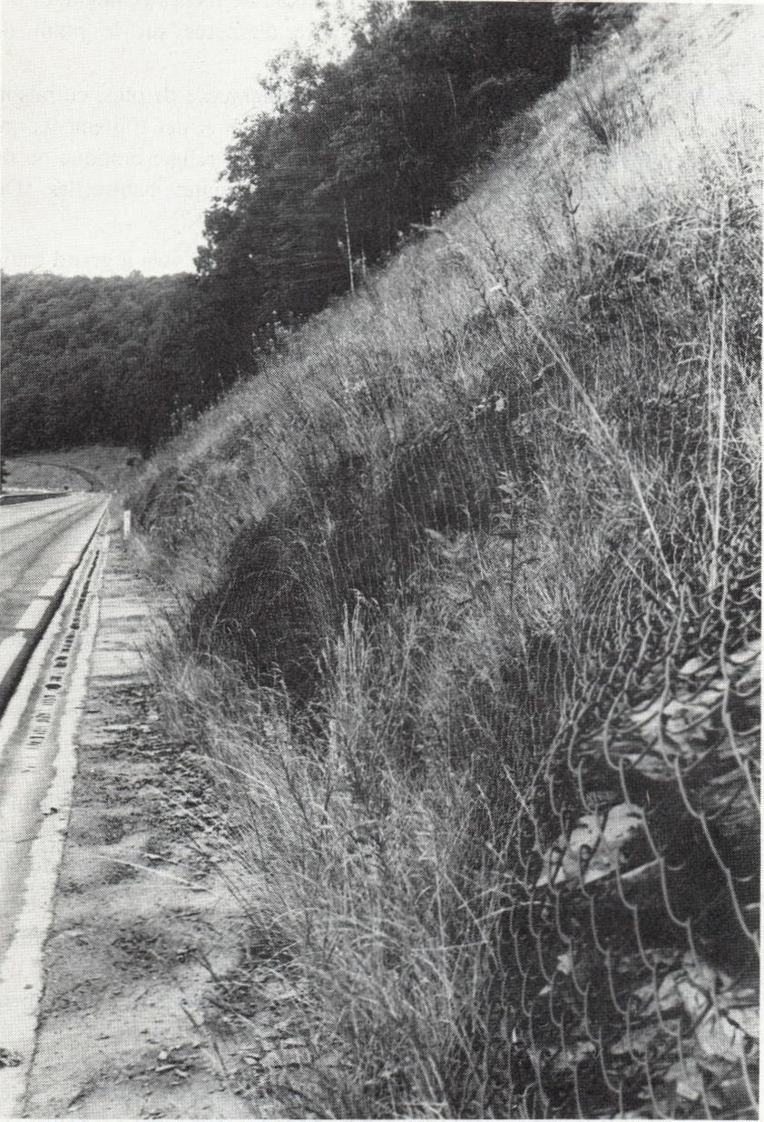
FIG. 2. — Treillis de protection sur un talus rocheux (Bouillon).
