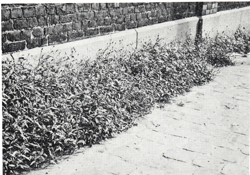
FIG. 5. — Au mois d'août, la végétation de cette fente murale est dominée par la Renouée persicaire (Rue des Étangs noirs à Molenbeek-St-Jean).
