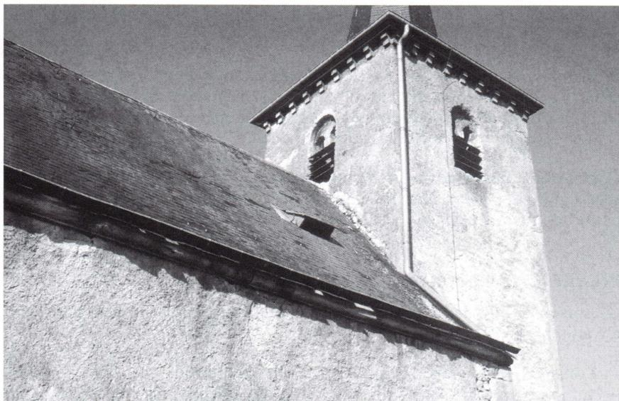
**Fig. 1.** Première chiroptière réalisée en Région Wallonne: Église de Metzert (Attert) 8.VII.1993. La chiroptière est une ouverture en toiture destinée à permettre l'accès des combles par toute espèce de chauve-souris susceptible de s'y reproduire, tout en interdisant le passage des pigeons et des effraies.
