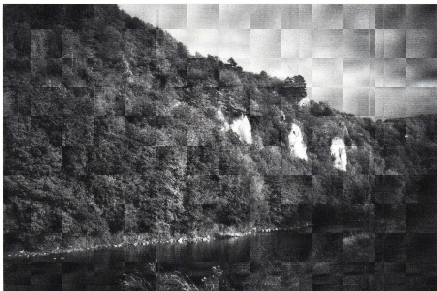
PHOTO 3. — Le Thier Pirard à Comblain-au-Pont : partie amont des rochers. On peut noter, en rive droite, l'important enrochement de la berge de l'Ourthe.
