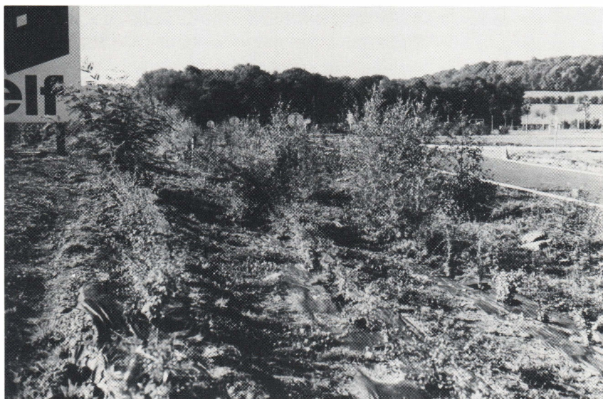
FIG. 8. — Plantation sur film plastique réalisée en France et permettant d'éviter l'emploi des herbicides ; cette nouvelle technique est également mise en œuvre pour les talus en pente forte (autoroute Nancy-Dijon, octobre 1985).
