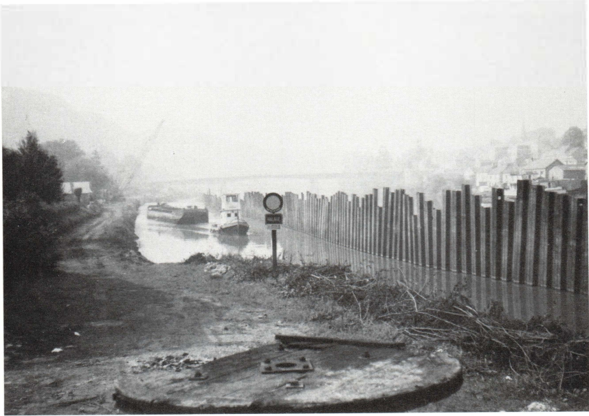
FIG. 3. — Namèche, 1982. Rectification de la rive droite de la Meuse.
