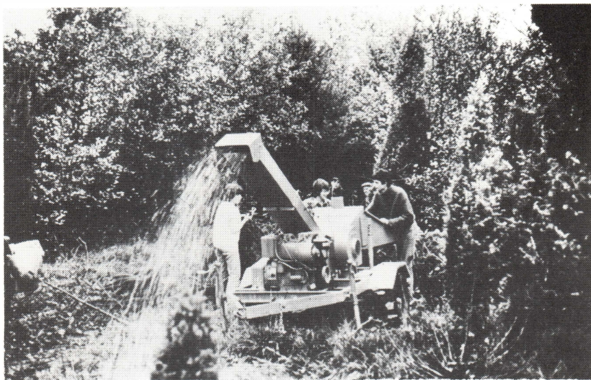
PHOTO 4. — Au lieu d'être brûlés, les débris végétaux ont été broyés à l'aide d'un puissant broyeur et ont servi de compost au Domaine Provincial de Chevetogne. (Photo Jean-François BUSLAIN).
