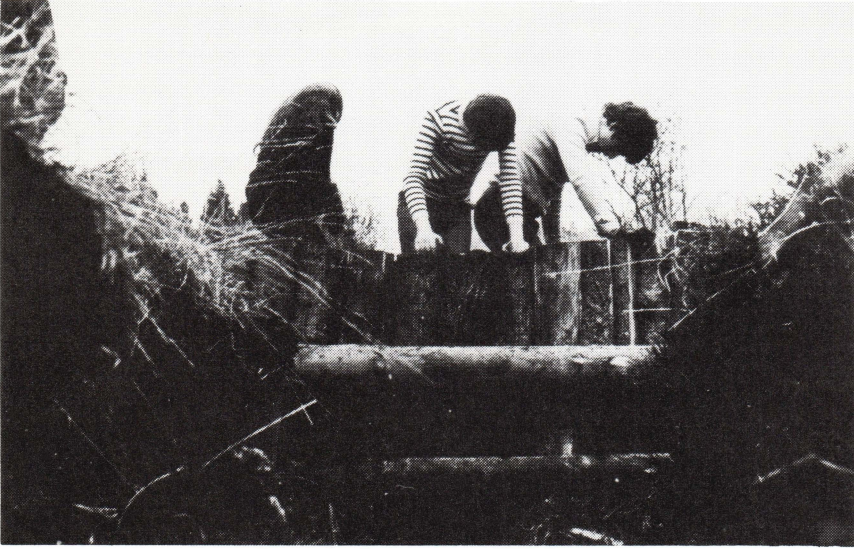
PHOTO 6. — Le tassement de la tourbe entre les deux palissades de chaque barrage constituait une opération capitale en vue de rendre celui-ci imperméable. (Photo Yves VAN CRANENBROECK).
