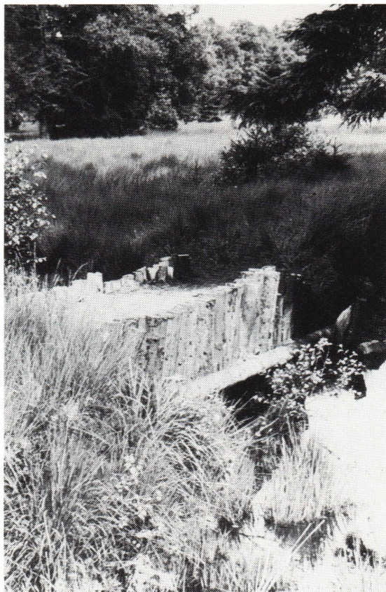
PHOTO 7. — Le barrage situé au confluent du drain périphérique et du drain principal un an après son érection. (Photo Yves VAN CRANENBROECK).
