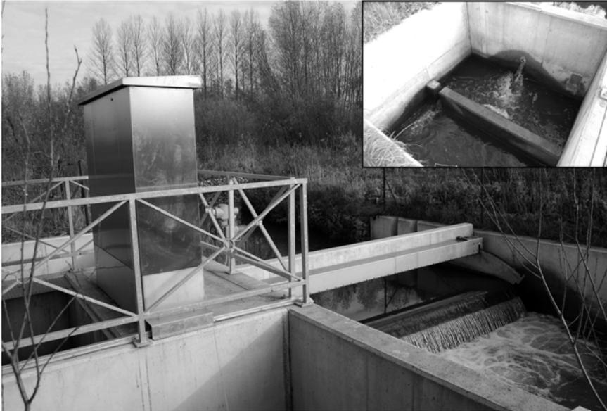
Fig. 4. Le barrage et, à gauche, la passe à poissons établis en 2000 à l'initiative du Parc naturel des Plaines de l'Escaut sur la Verne à Wiers (Péruwelz). En haut, à droite, un bac de la passe permettant la remontée des poissons.
